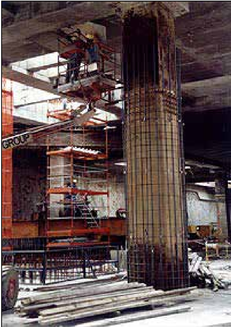
▲ اجرای فرآیند تاپ - دان در طبقات زیرزمین. شمع‌های فولادی که پیش از اجرای خاکبرداری نصب شده‌اند در این تصویر دیده می‌شوند که دال سقف‌ها را نگاه می‌دارد
