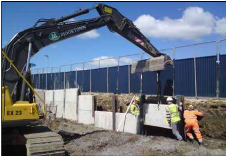
▲ ساخت دیوار شاه تیر در کالج کسب و کار باترشا، انگلستان
